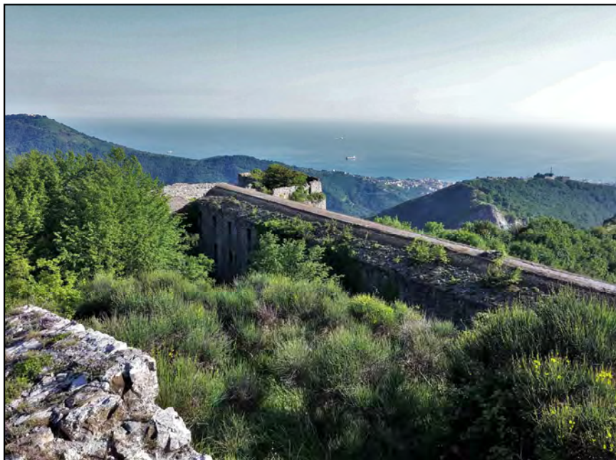
La posizione panoramica del Forte Ratti, ben visibile nell'immagine (foto dell'autore)
